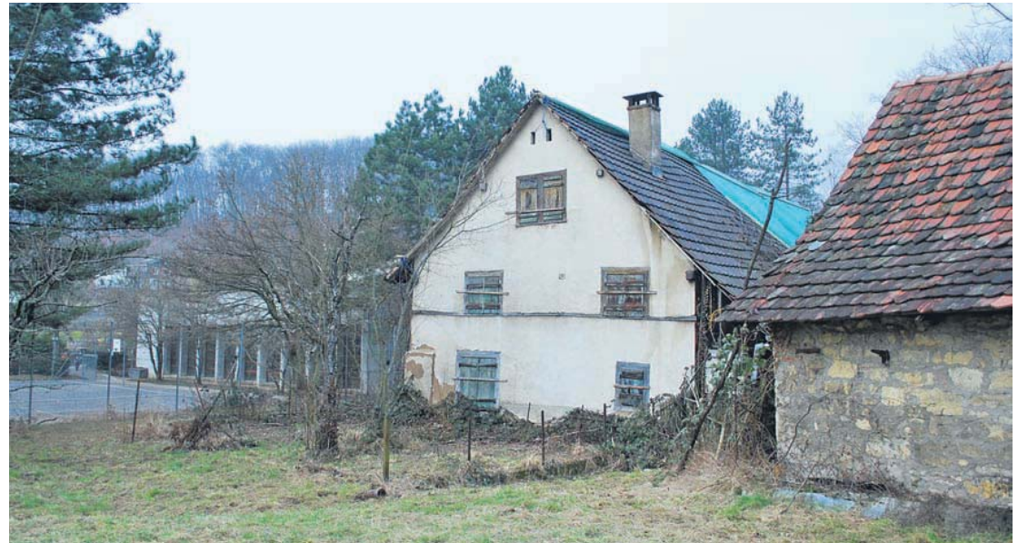
Das jahrhundertalte Haus an der Steinengasse 5, im Hintergrund ist das Schulhaus zu sehen.
